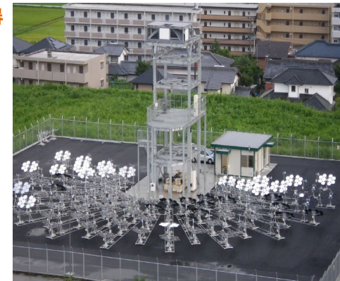
宮崎大学と共同で建設した100 kW級の太陽光集光システム等を用い、水熱分解水素製造の作動原理を実証。
